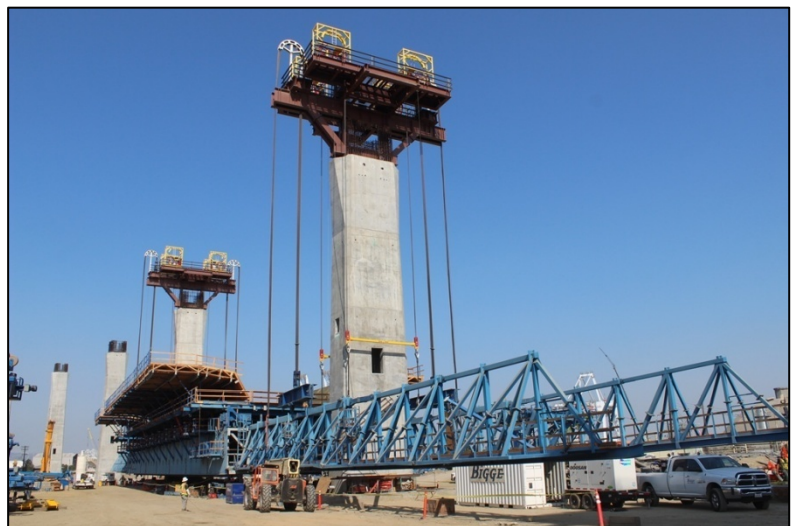
Figura 7. Montaje 2, conexión cables de izado
