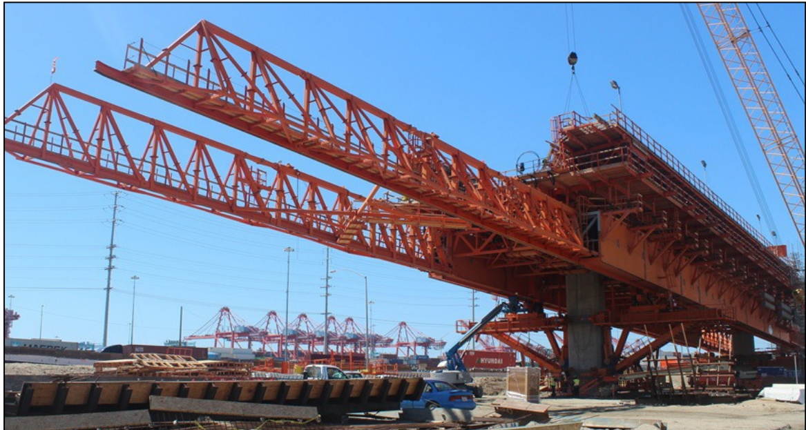
Figura 5. Montaje 1, modular sobre ménsulas
