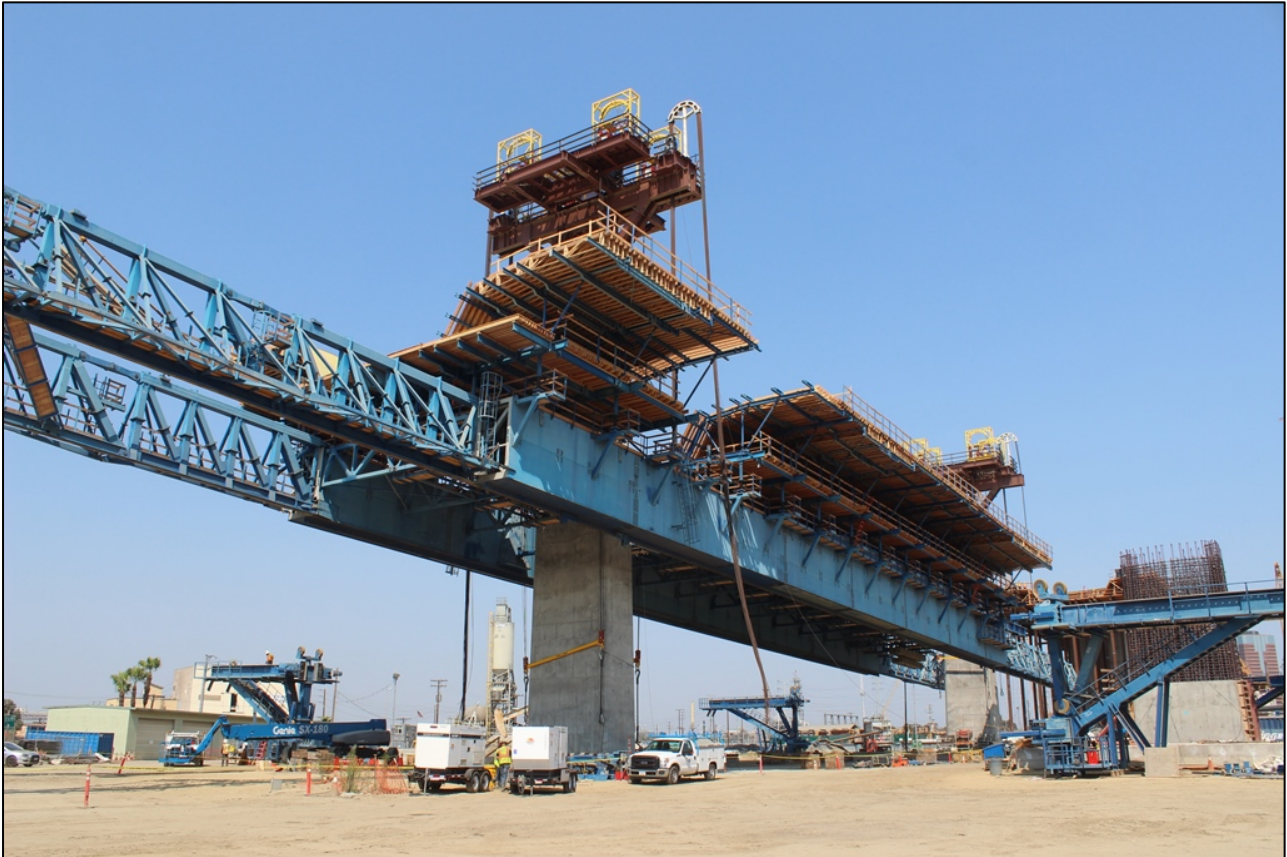
Figura 8. Montaje 2, operación de izado de la Autocimbra
