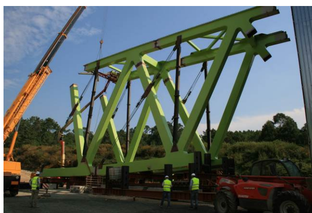
Figura 8b. Dos dovelas montadas en blanco
