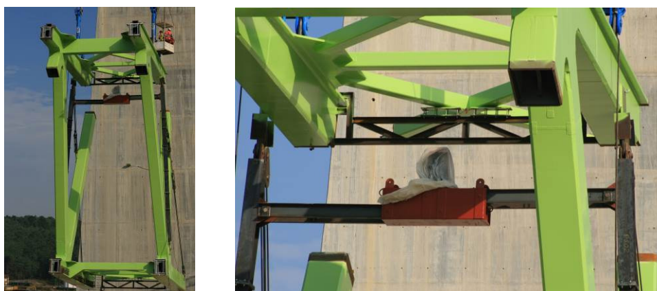
Figuras 13. Útil retráctil transversal para la retirada de elementos de arriostramiento
