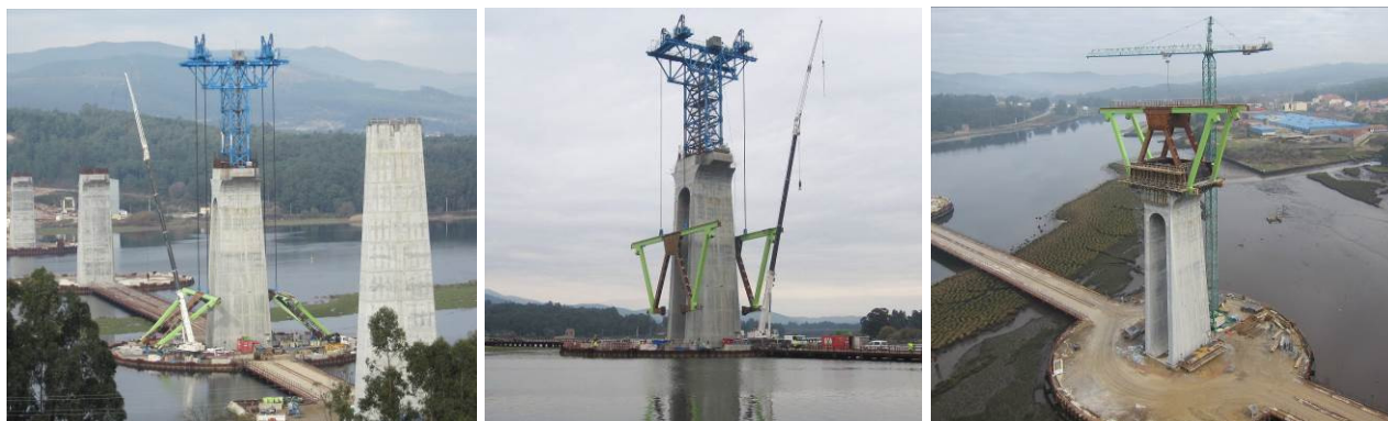
Figura 4. Verticalizado, izado de la dovela cero y ejecución de la cabeza de hormigón de P-5
