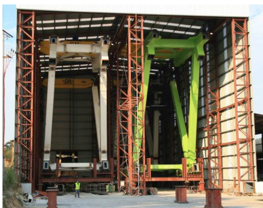
Figuras 7a y 7b. Nave doble para ensamblaje de dovelas junto a P-4 y nave de ensamblaje junto a P-9
