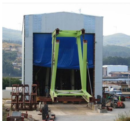
Figuras 7a y 7b. Nave doble para ensamblaje de dovelas junto a P-4 y nave de ensamblaje junto a P-9
